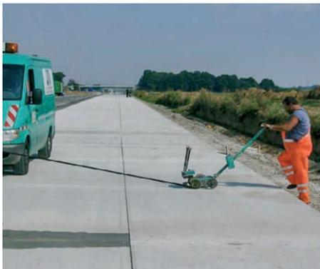
Bild 4: Einbau eines Elastischen Profils
