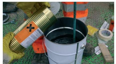
Bild 3: Mischen eines zweikomponentigen Dichtstoffes
