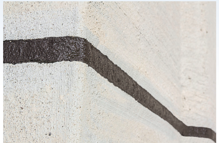
Bild 2: Detail: Fuge mit TOK®-BSW in einer Betonschutzwand
