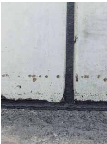
3 Kreuzpunkt Boden-Wandanschluss.
