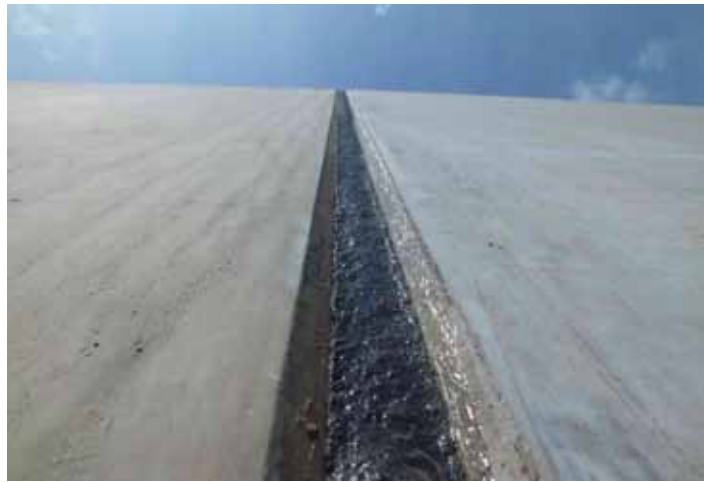
6 Vertikal eingebaute Fugenmasse.
