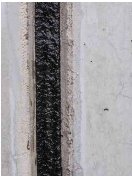
Abbildung 6: Frisch hergestellte Vertikalfuge
