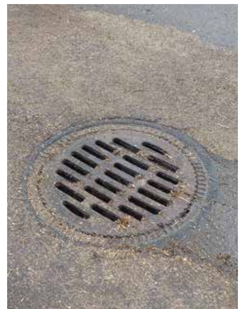
Abbildung 8: Ablauf zum Auffangbecken
