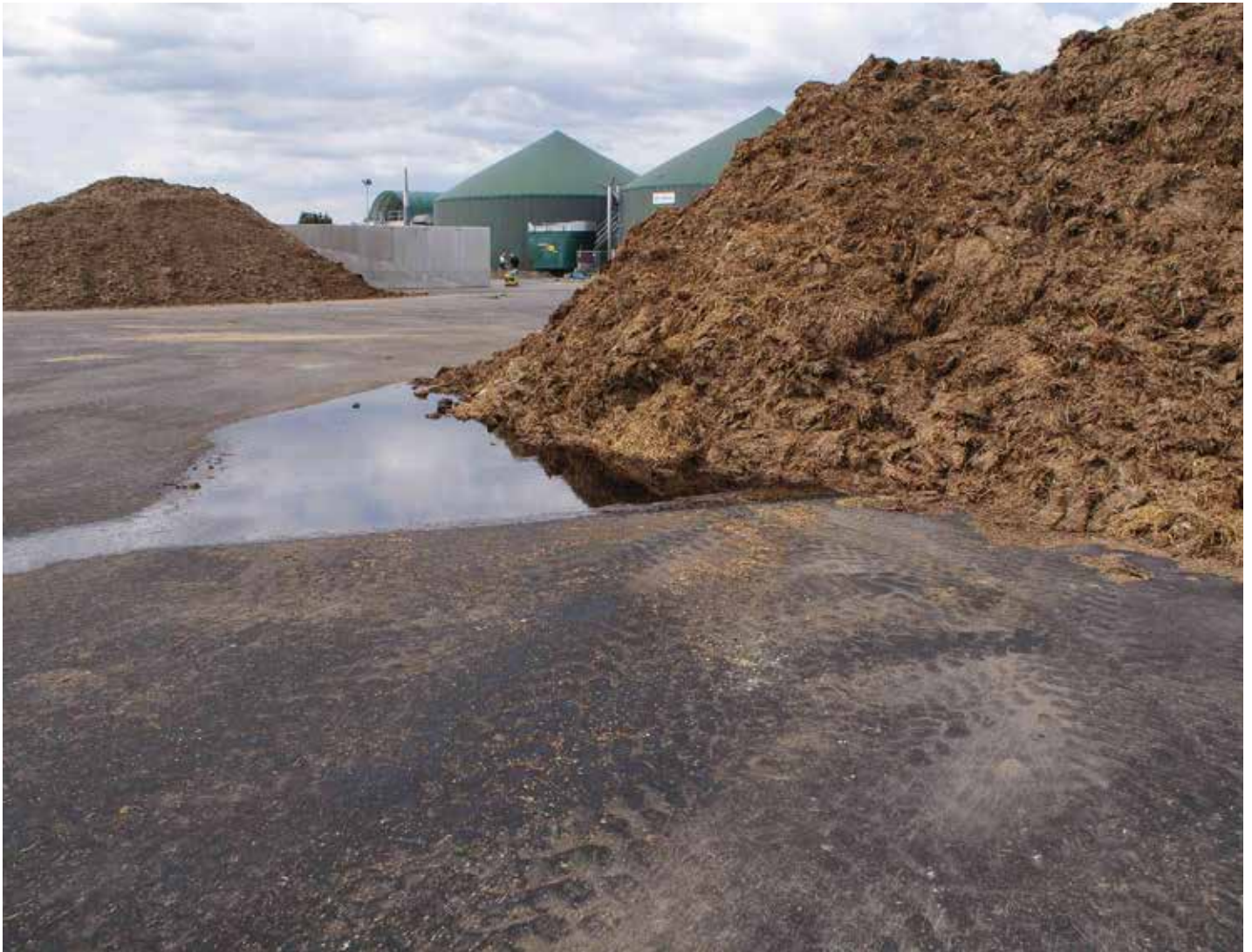
Abbildung 1: Fahrсило an einer Biogasanlage.
