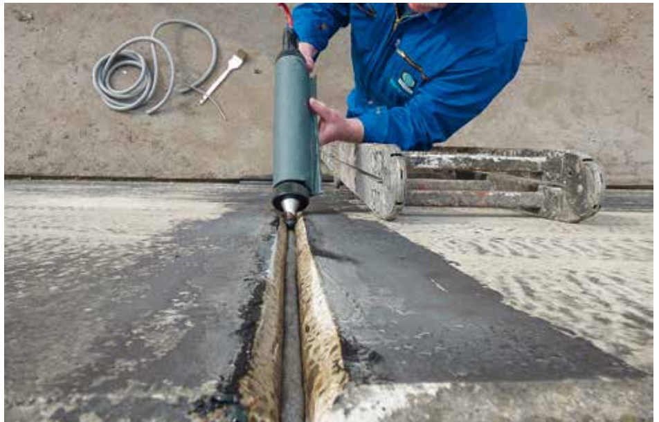
Abbildung 5: Einbau der Fugenmasse Tok-Silresist
